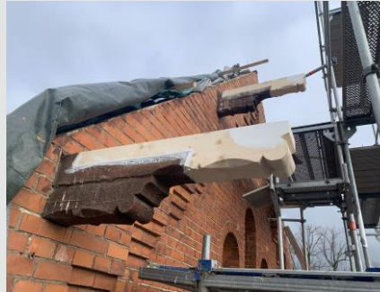
Reparatur schädlingsbefallene Pfette im Außenbereich
