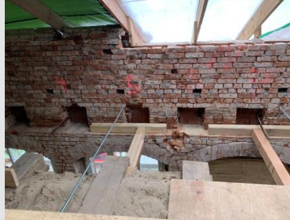
Schädlings-Befallene Deckenbalken ausgebaut, Mauerwerkaufleger
