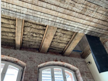
Geschossdecke 2.OG/DG Bestand mit Lehmwickeln Zustand vor Beginn Holzschwammsanierung
