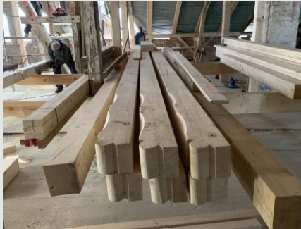
Neue Sparren – Herstellung Zierornamente auf der Baustelle
